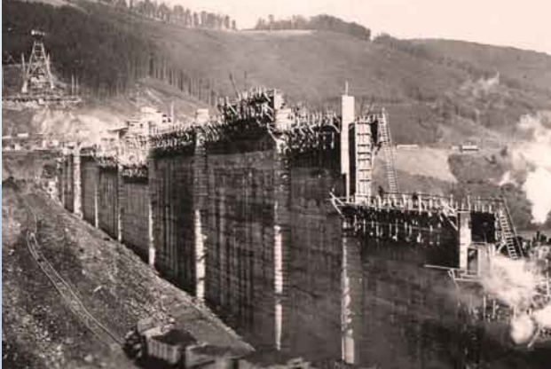
Bau der Betonkerndichtung der Hauptsperre – Blick von der Luftseite
