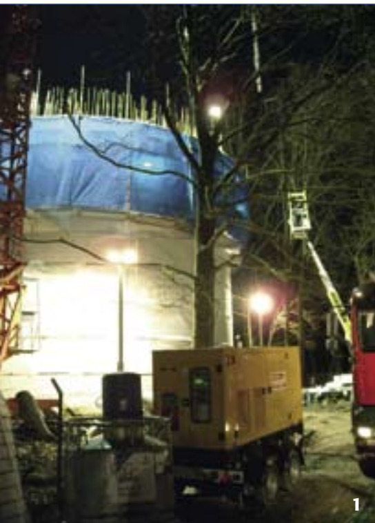
1 Nachtschicht inklusive: Der Bau des neuen Wasserhochbehälters in Groß Brunnsrode entstand durch Betonierung rund um die Uhr. 2 + 3 Innerhalb von vier Tagen und Nächten wurden im Dezember 2008 die Betonwände gegossen, um fugenfreie, glatte Wandinnenflächen zu bauen. 4 Präzise Arbeitsschritte und wirtschaftliche Bauweise zeichnen die Bauexperten der Harzwasserwerke GmbH aus.
