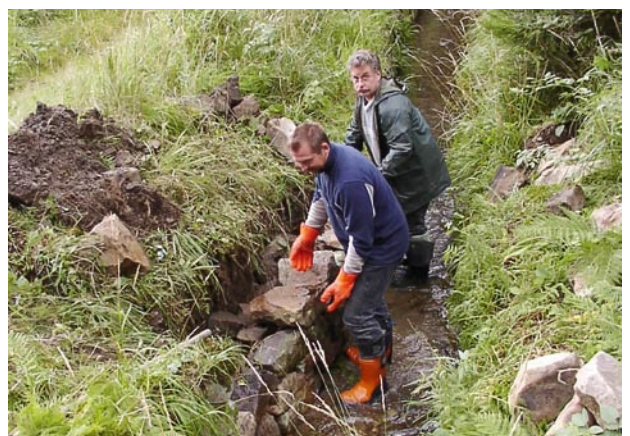
Instandsetzungsarbeiten am Morgenbrodtsthaler Graben
