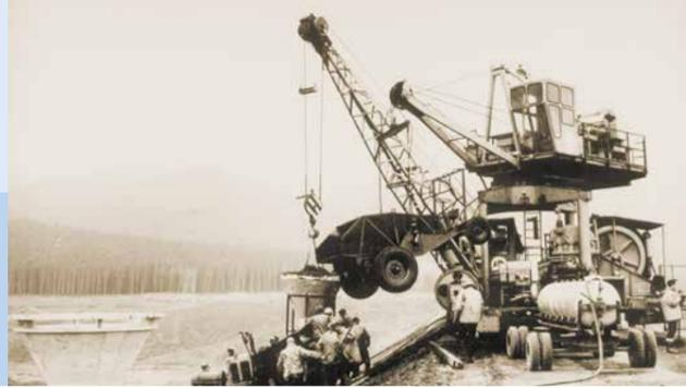
Aufbringung der mehrschichtigen Asphaltbetondecke
