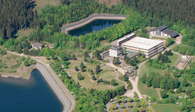
Das Wasserwerk Granetalsperre
