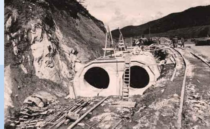
Bau der Betonkerndichtung der Hauptsperre –
