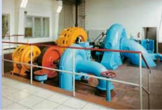
Turbinen zur Erzeugung von Strom aus Wasserkraft
