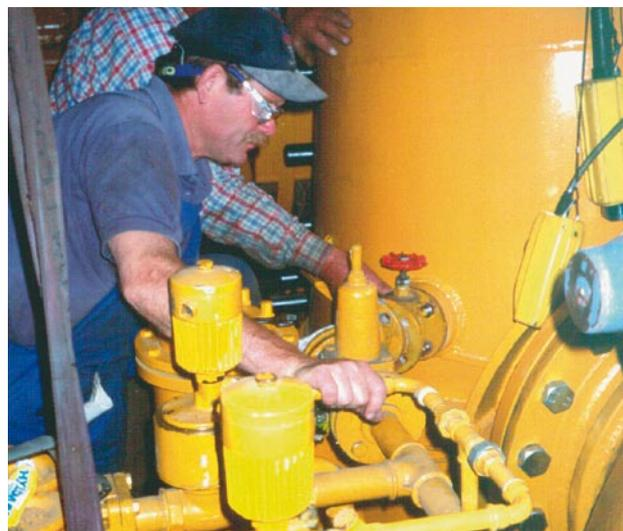
*Wartungsarbeiten an der Francis-Turbine im Kraftwerk an der Okertalsperre*
