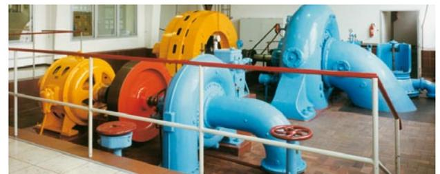
Zwei Francis-Turbinen mit Generatoren im Kraftwerk an der Sösetalsperre
