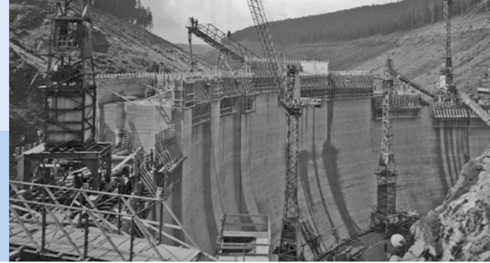
Bau der Bogengewichtsstaumauer in den 1950er Jahren
