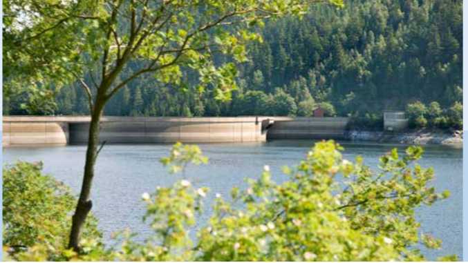
Seit 1956 dient sie erfolgreich dem Hochwasserschutz
