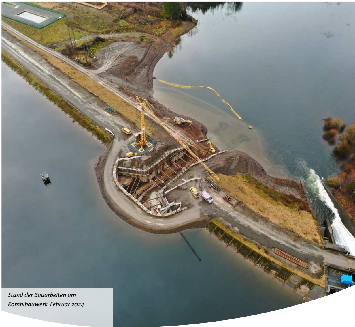
Das Kombibauwerk fasst Hochwasserentlastungsanlage und Grundablass in einem Bauwerk zusammen.
