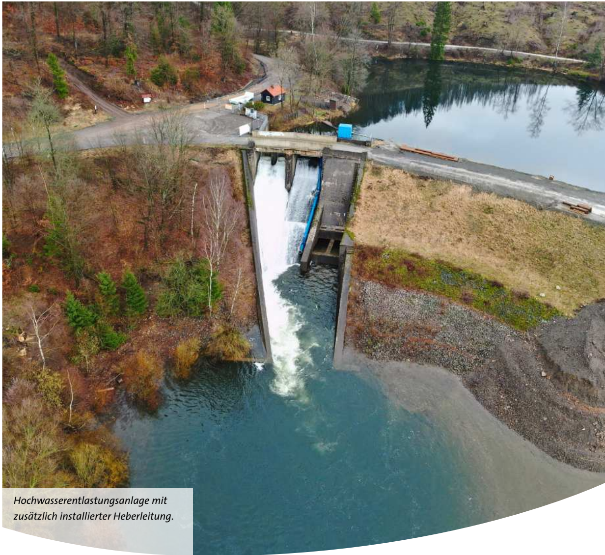
Die Brücke der Bundesstraße überspannt die Heber, den Überlauf sowie den Dammbalkenverschluss der Vorsperre.
